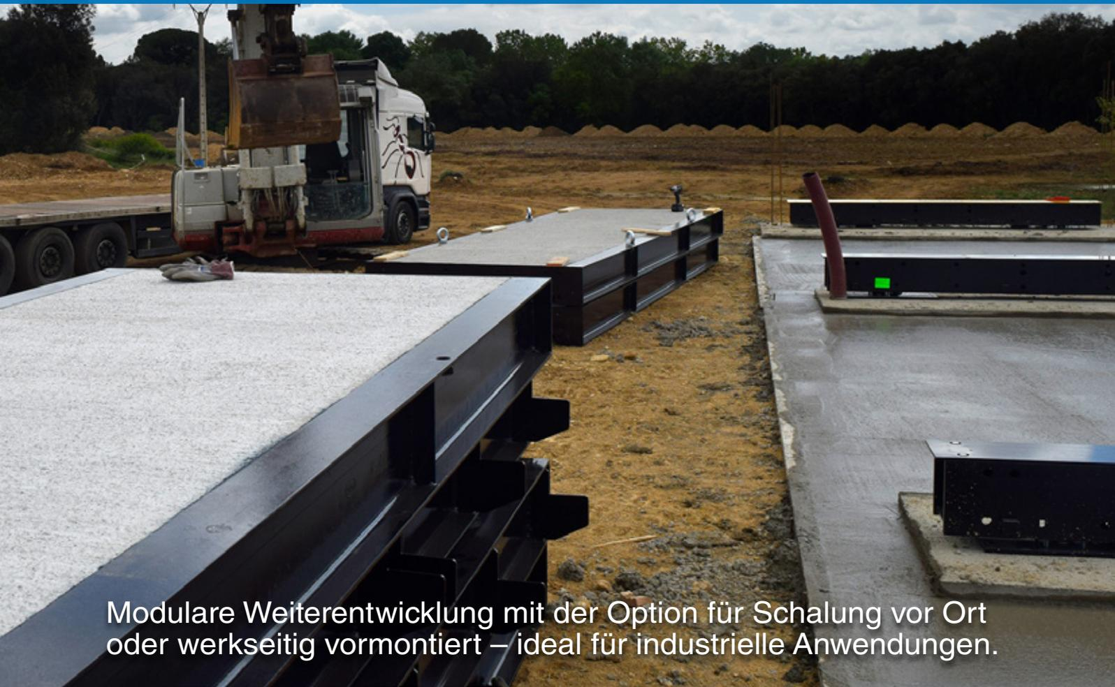
Modulare Weiterentwicklung mit der Option für Schalung vor Ort oder werkseitig vormontiert – ideal für industrielle Anwendungen.
